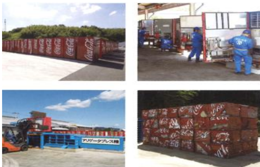
写真6 自動販売機の回収と解体作業
